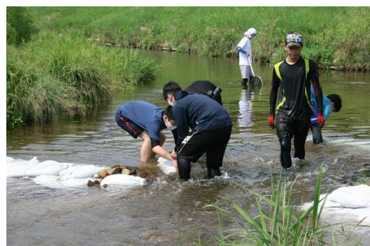
図3 バーブエ(水制工)作り
