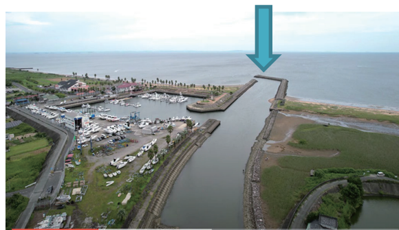
図9 砂州がなく、導流堤がある田中川
