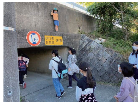
天井川地形特有の水路橋をくぐる様子。歩行路の上を川が流れている。
